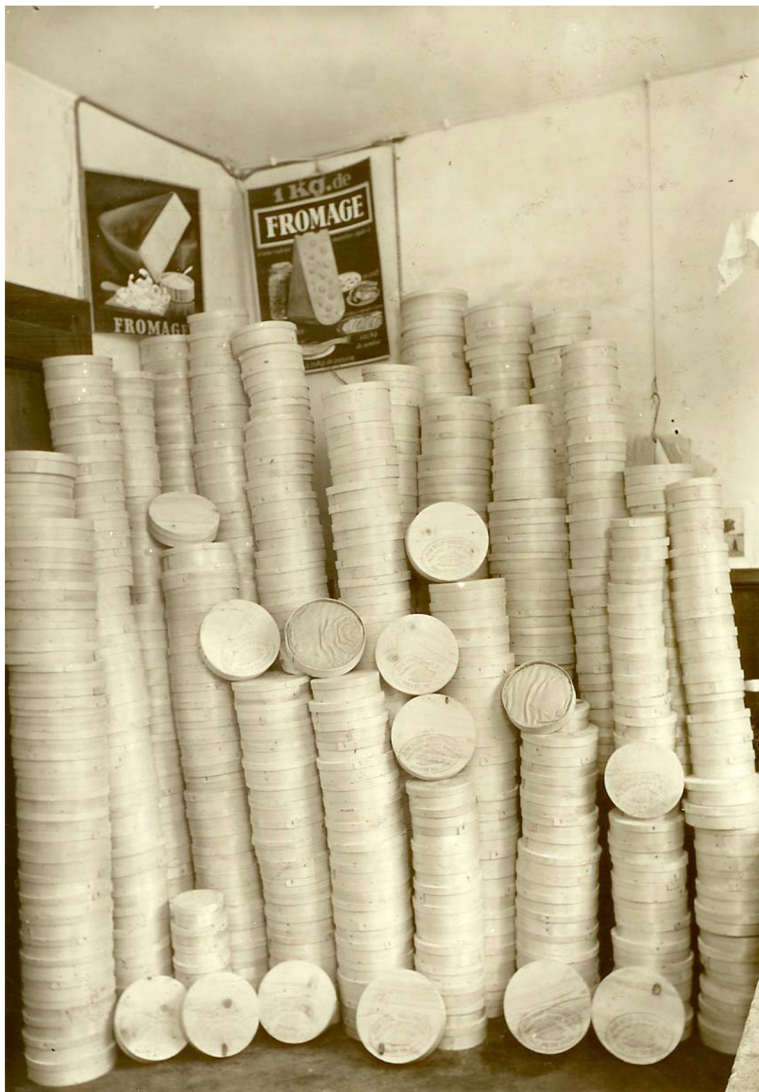
Stock de boîtes vides chez un gros affineur de la région. Les boîtes remplies ne sont là que pour le temps d'une photo, car il ne serait pas possible de procéder à un tel entassement avec des boîtes pleines, vu que les emballages ne résisteraient pas à un tel poids.
